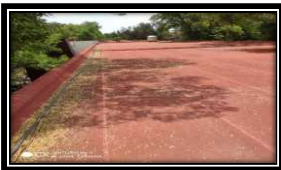
Se barrieron las azoteas y se limpiaron coladeras en todos los edificios y auditorios.
