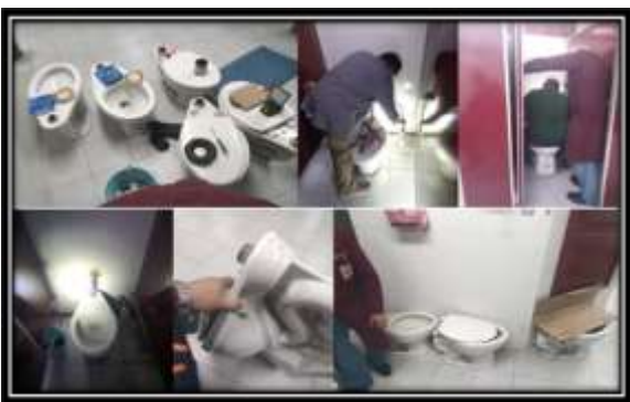
Reparaciones en los baños.
