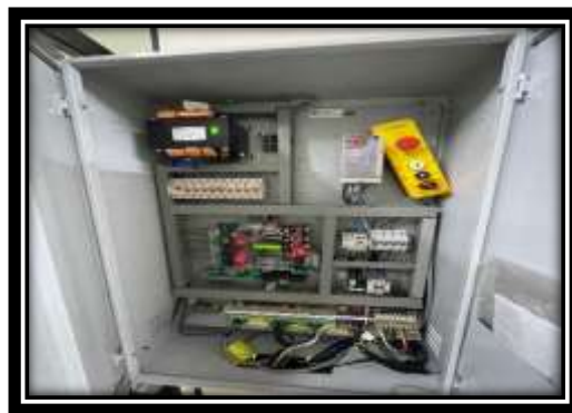
Reparación y mantenimiento de tablero eléctrico del elevador ubicado en el Edificio D, realizando las pruebas correspondientes.
