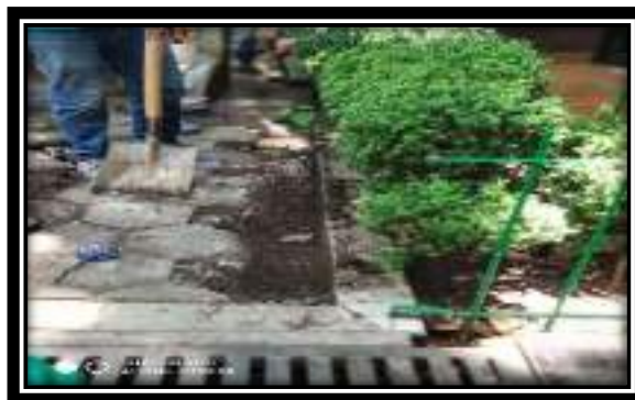
Se escavo en áreas comunes para cambio de tubería de agua potable.
