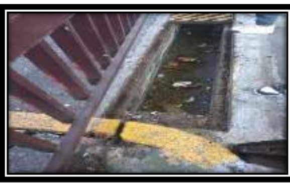
Se realizó la limpieza en rejillas y coladeras en el estacionamiento.
