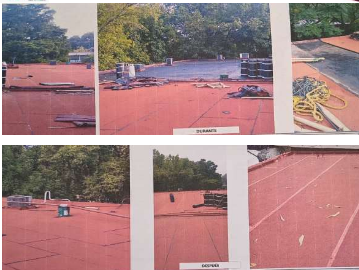
Se realizan los trabajos de Impermeabilización en los Edificios D, E, F, Biblioteca, Caseta de vigilancia, Caseta de Vigilancia basura, y cafetería naranja-limón.
