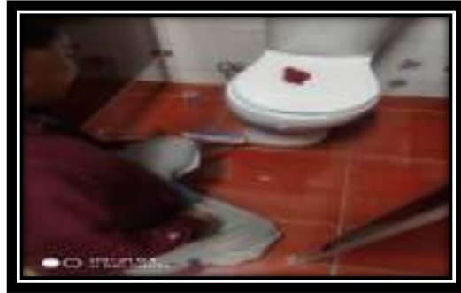
Reparaciones en todos los baños
