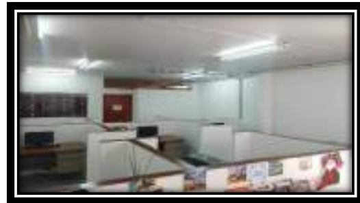
Se coloco pasta y se pintó el área de Tutorías del edificio "C" segundo piso
