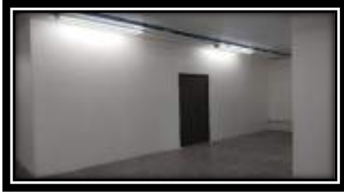
Se llevó a cabo el servicio de pintura en muros de Tablaroca que se instalaron en el salón CADE.
