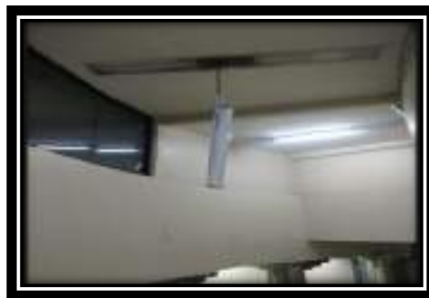
Se realizó la instalación y reparación de lámparas en baños, pasillos y salones del Edificio A, F, G y en escalera del Hall primer piso.
