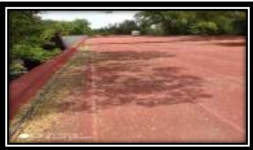
Se barren azoteas y se limpian coladeras en edificios, Auditorios y Biblioteca
