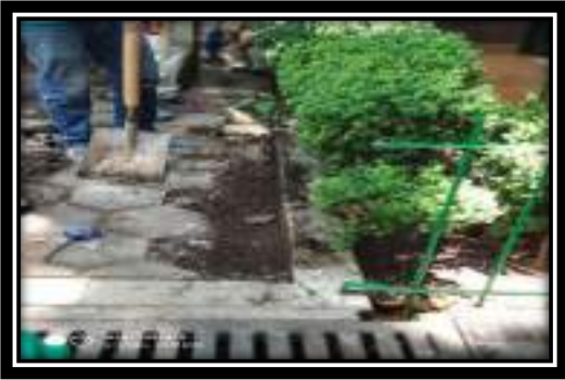
Cambio de tuberías de agua potable en áreas comunes
