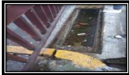
Se realizo limpieza en rejillas y coladeras del estacionamiento
