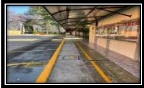
Se remarcaron líneas de estacionamiento y banquetas
