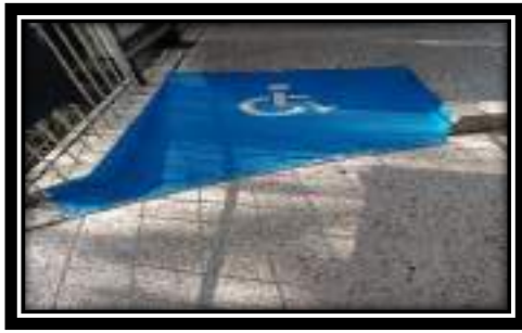
Pintura en señalización y líneas de tránsito peatonal
