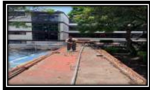
Se realizo limpieza en techos de andadores en áreas comunes
